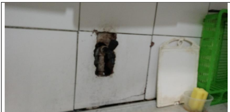
Foto - Abertura na parede da cozinha, Ilha de Itamaracá (PE), 01 de julho de 2016
