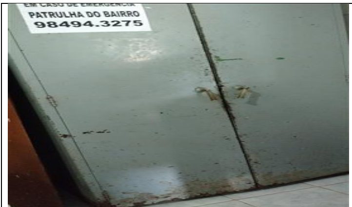
Foto - Ferrugens – Foco de insabubridade, , Ilha de Itamaracá (PE), 01 de julho de 2016
