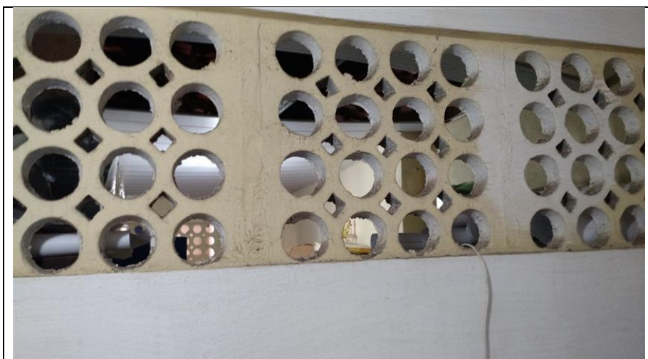
Foto - Abertura na cozinha sem tela de proteção milimétrica, Ilha de Itamaracá (PE), 30 de junho de 2016
