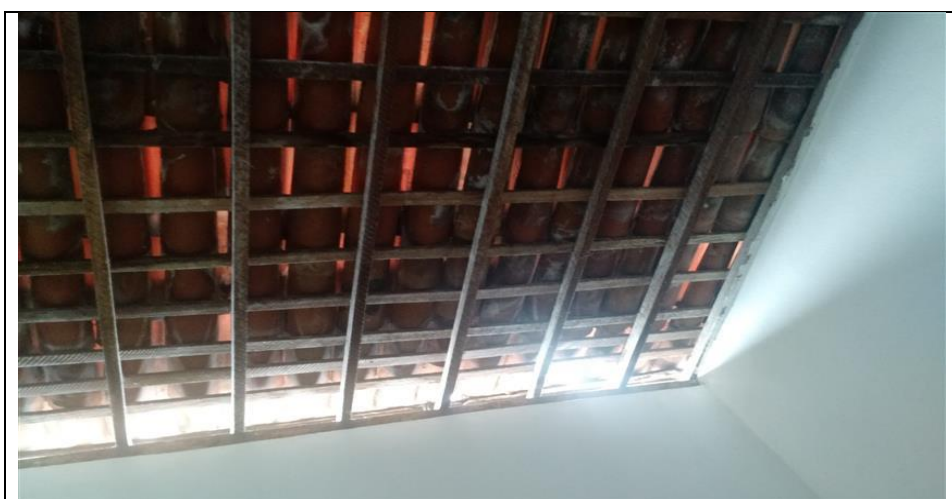
Cobertura do local de armazenamento do gêneros alimentícios com aberturas
