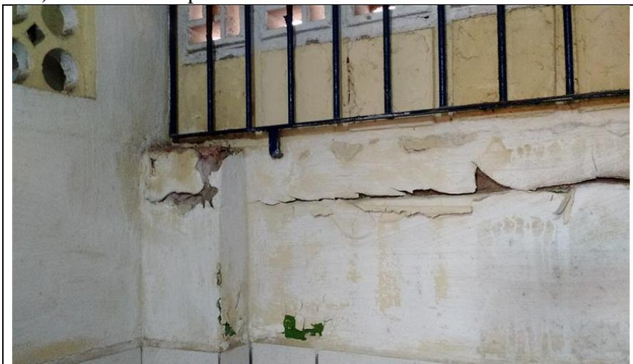
*Foto - Infiltração na parede da cozinha, Ilha de Itamaracá (PE), 30 de junho de 2016*
